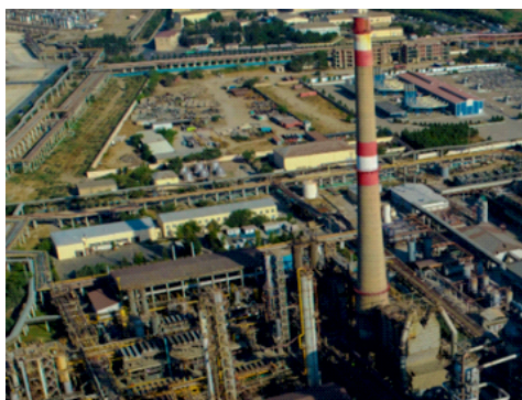
Установка каталитического крекинга на нефтеперерабатывающем заводе
